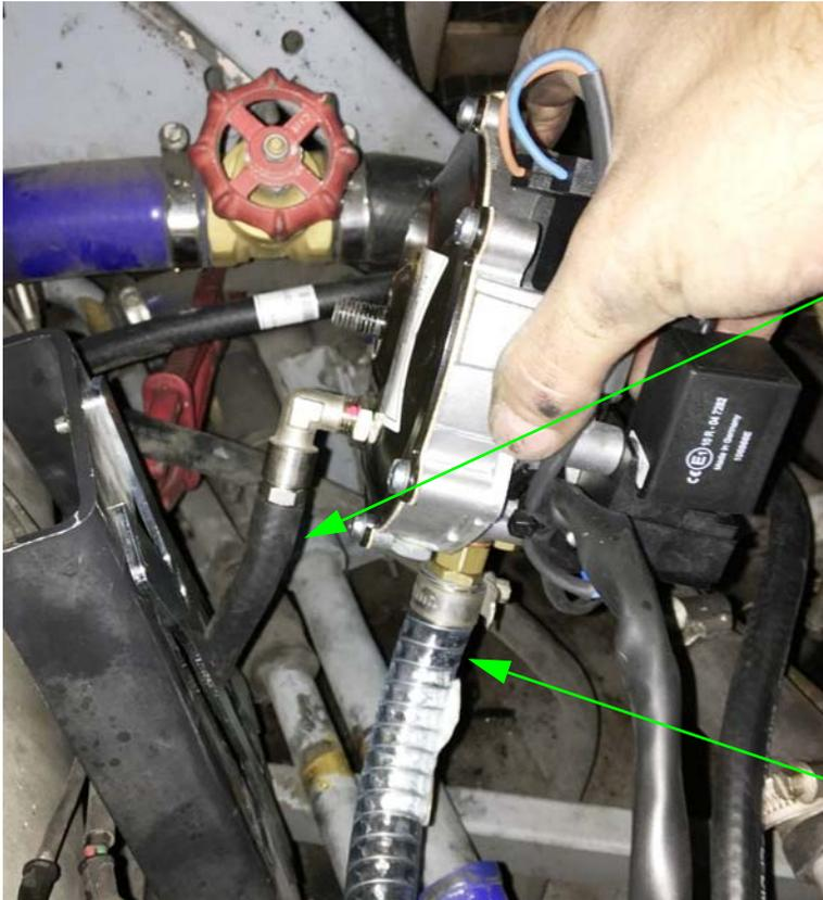
Schlauch auf Referenzdruckstutzen befestigen
